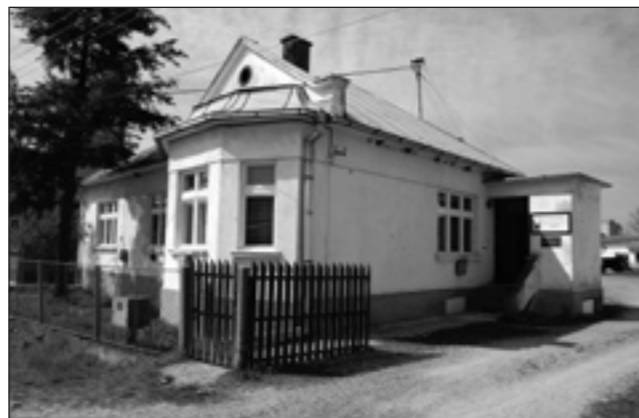
Budova lesnej správy
